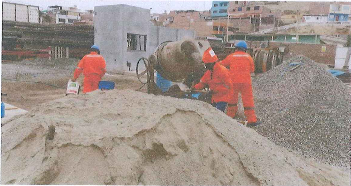
PRODUCCION DE CONCRETO
