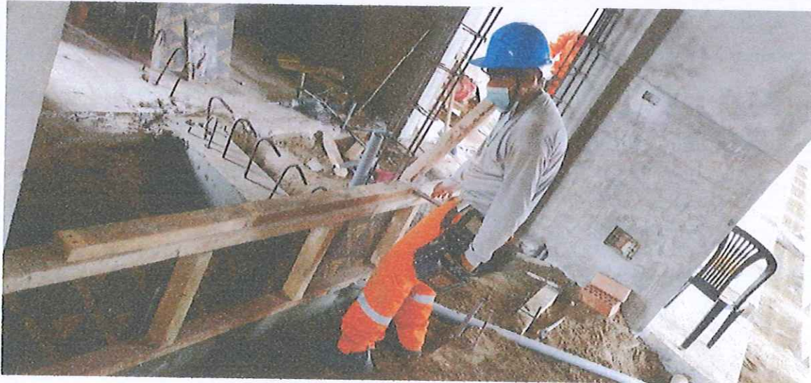
ENCOFRADO DE ESTRUCTURAS
