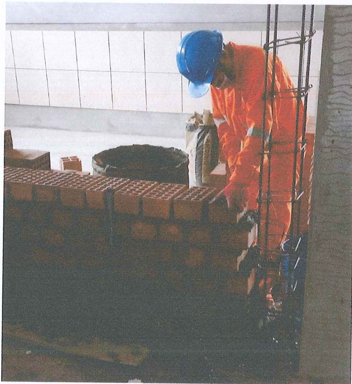
ASENTADO DE LADRILLO
