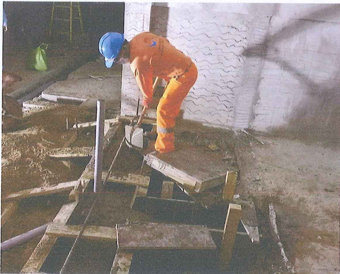
VACIADO DE CONCRETO EN CIMENTACION
